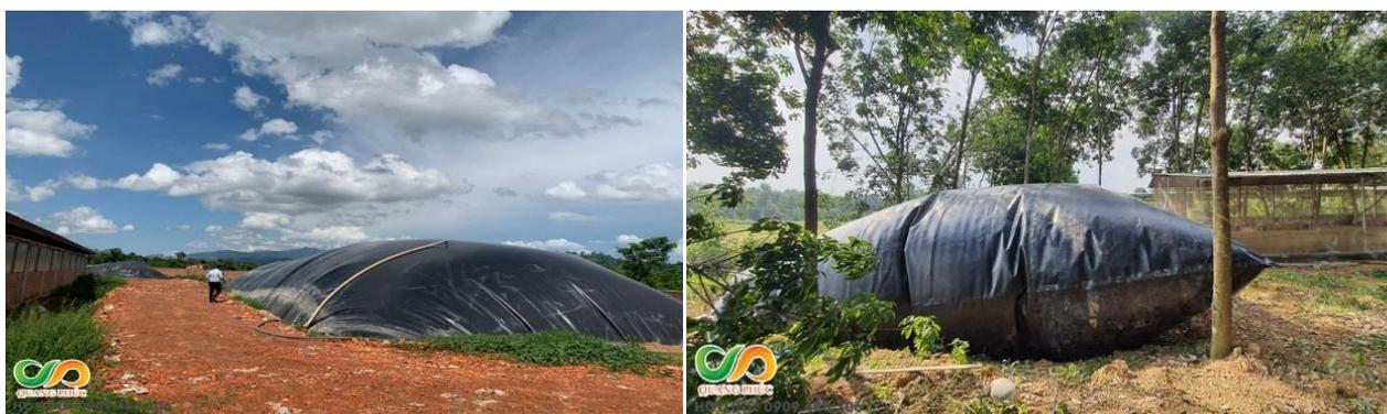
Рис. 1 Хранение биогаза в полиэтиленовых мешках при атмосферном давлении
